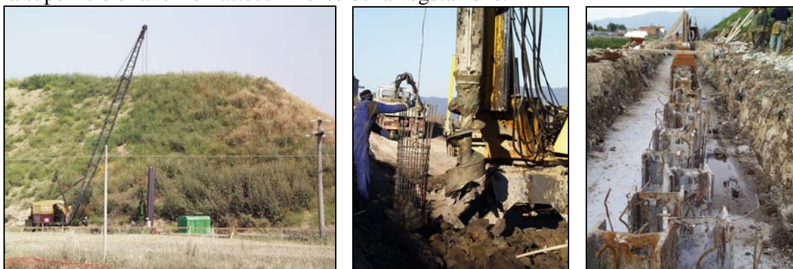
Le fondazioni del muro di sostegno profonde 6 metri a ridosso del versante in frana.
