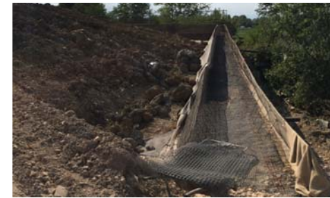
Realizzazione terre rinforzate su tutto il perimetro
