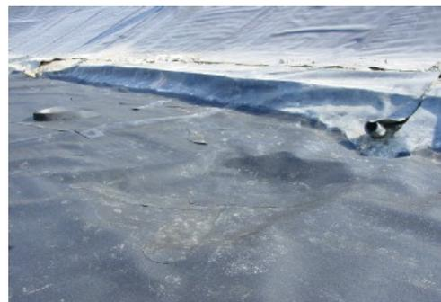
La geomembrana in HDPE dovrà essere resa solidale a quella già posata in opera sui primi tre gradoni della vasca 2B.
