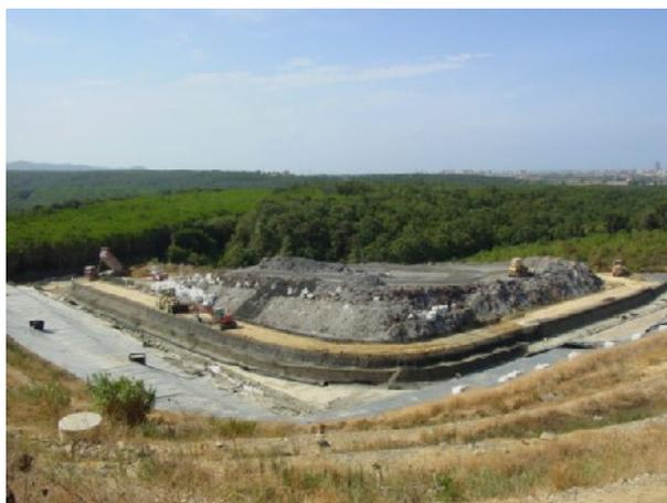
previsto in terra rinforzata con paramenti inclinati a 65°, altezza variabile da 4 a 5 metri e larghezza costante in testa di 3.50 metri. La sagoma, pur esuberante rispetto le necessità statiche è stata preferita a soluzioni più limitative per garantire l'agevole passaggio dei mezzi di gestione e manutenzione. Il riempimento è quindi previsto con sagoma finale a
