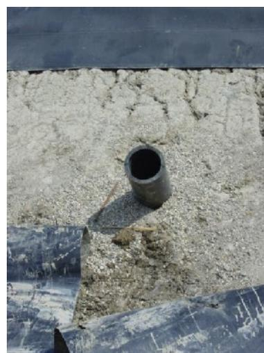
Per favorire il deflusso del percolato verso le perforazioni inclinate il piano interno dell'arginatura verrà realizzato con doppia inclinazione verso l'interno della vasca e con direzione Nord-Sud. Al piede dell'argine esistente è prevista la posa di una tubazione drenante in HDPE DN 250 PN 16 su cui stendere uno strato drenante in ghiaia di spessore
