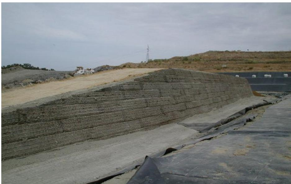
Il muro in terra rinforzata è stato studiato mediante 17 sezioni caratteristiche.
